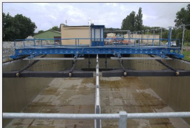
9. září 2011 – Dokončení sanace usazovací nádrže
