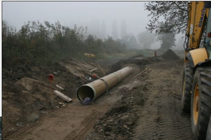
14. říjen 2010 – Pokládku laminátového potrubí nezastaví ani mlha nad řekou
