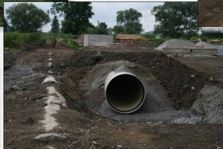
30. červenec 2010 – Nové a staré potrubí sběrače
