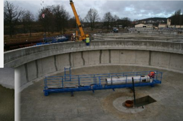
20. listopad 2010 – Stěhování technologické výstroje do nádrže dosazováku DN 4 před montáží
