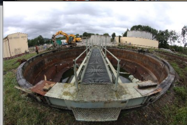
8. září 2011 – Demolice BF linky, vybourání vstrojení nádrže dosazováku DN BF 1
