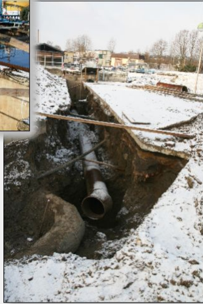
21. leden 2011 – Připravené provizorní potrubí nátoku na aktivační linku
