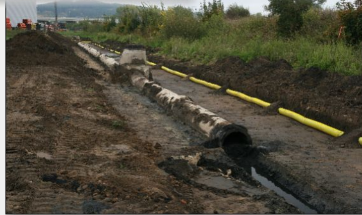
6. říjen 2010 – Bourání původního potrubí sběrače pokračuje dalším úsekem. Žluté potrubí představuje obtok staveniště z původního sběrače do shybky
