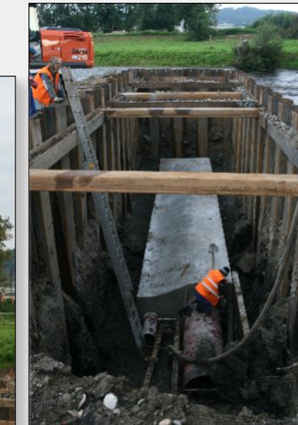
1. září 2010 – Položené litinové potrubí shybky pod betonovou zálivkou
