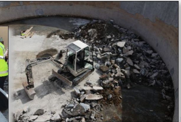
25. březen 2011 – Bourání starého dna při sanaci uskladňovací nádrže kalu
