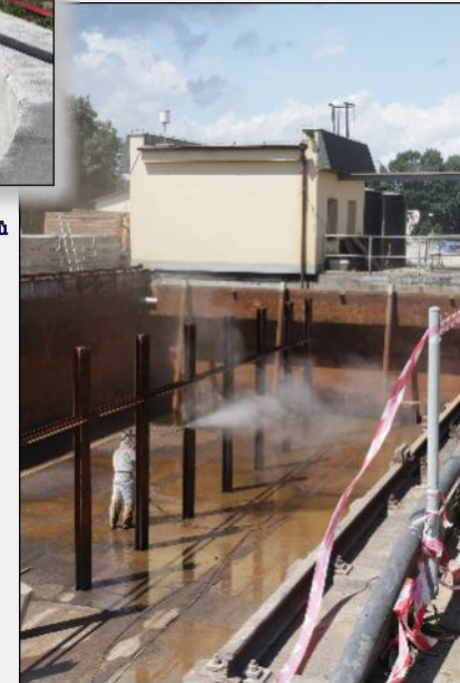
7. červen 2011 – Usazovací nádrž – čištění povrchů tlakovou vodou
