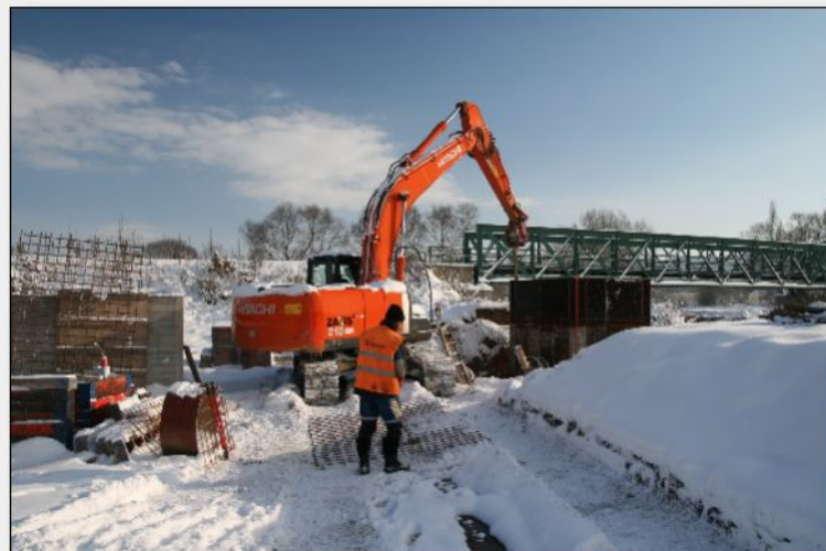
2. prosinec 2010 – Armování a bednění počáteční šachty shybky pod řekou Otavou
