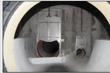
Levobřežní armaturní komora na shybce pod Otavou – nátok do shybky
