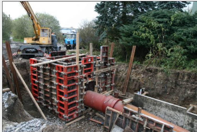
19. říjen 2010 – Zaarmovaná koncová šachta nové shybky po řekou Otavou těsně před betonáží stěn šachty
