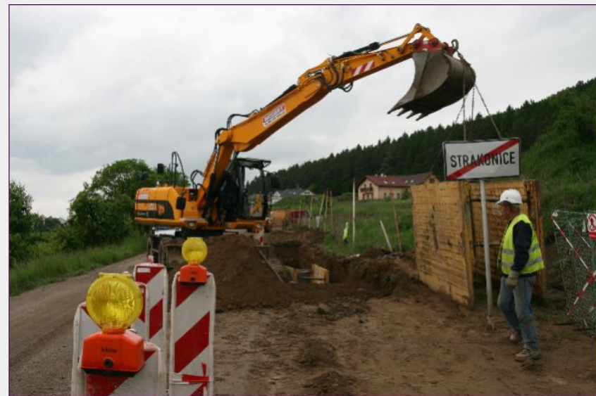
27. květen 2010 – Provádění výkopu a pokládky potrubí s ocelovým pažením
