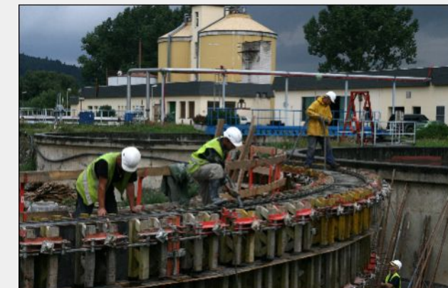
3. srpen 2010 – Betonáž stěny dosazovací nádrže DN 4
