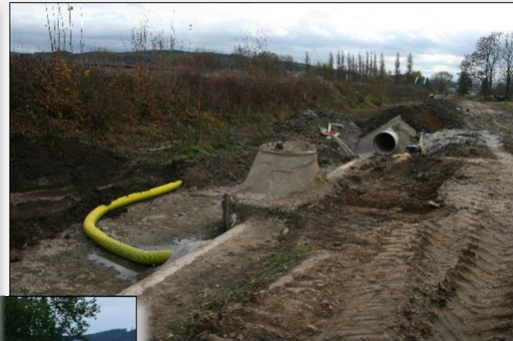
4. listopad 2010 – Staveniště s obtokovým potrubím
