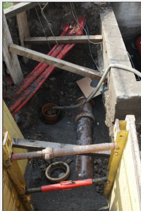
28. duben 2011 – Pokračování prací na přestavbě stávající čerpací stanice na dešťový oddělovač nového sběrače
