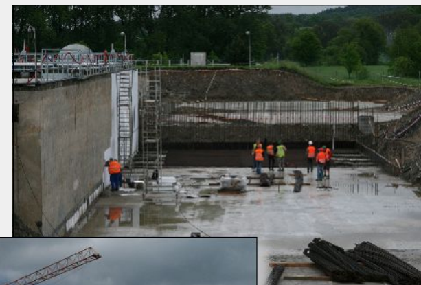
27. květen 2010 – Armování dna nové nitrifikační nádrže
