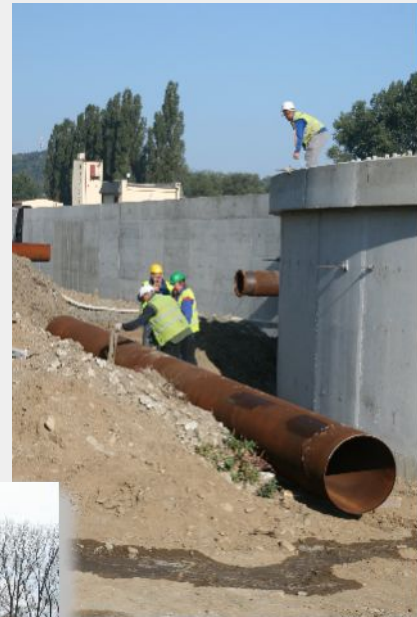
21. září 2010 – Montáž kalového potrubí z nové aktivační do nádrže DN 4
