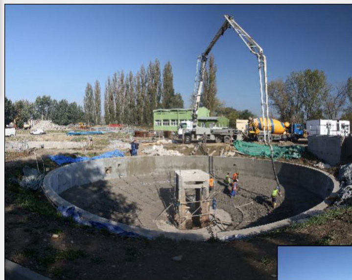
18. říjen 2011 – Betonáž dna nádrže dešťové zdrže DZ 2
