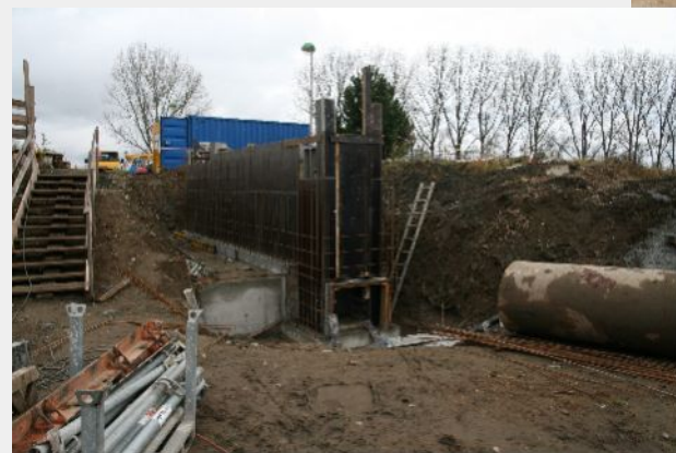
8. listopad 2010 – Armování stěn nového odtokového objektu ČOV
