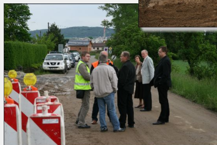
27. květen 2010 – Kontrolní den na stavbě
