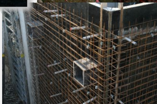
2. listopad 2010 – armování stěn čerpací jímky vratného kalu
