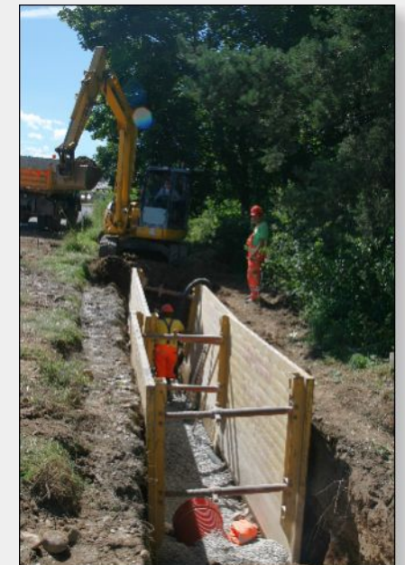
26. srpen 2010 – Práce ve výkopu za Mutěnickým mostem
