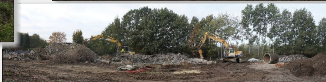
20. říjen 2011 – Dokončování demolice BF linky – rozbití základové desky BF 2
