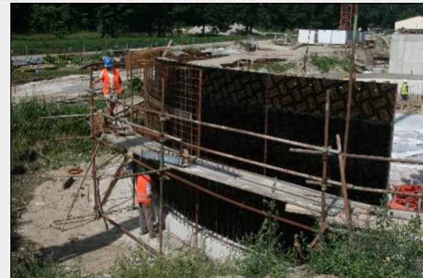
28. červenec 2010 – Armování a bednění stěn dosazovací nádrže DN 4
