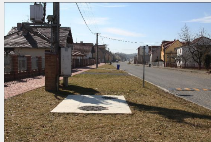
25. listopad 2011 – Dokončená výstavba dešťového oddělovače na novém sběrači
