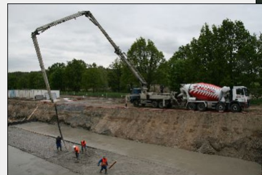
19. květen 2010 – Betonování základové desky nádrže kontaktoru
