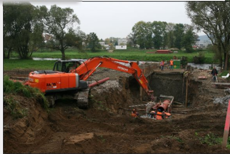
5. říjen 2010 – Budování vzestupné větve shybky pod řekou Otavou na pravém břehu
