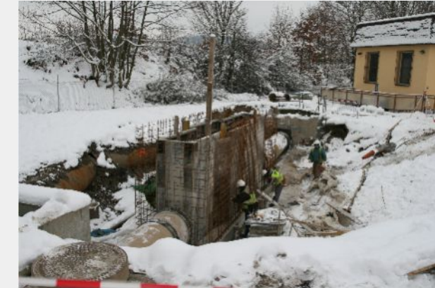
1. prosinec 2010 – Výstavba nádrže lapáku šterku na nátoku na ČOV
