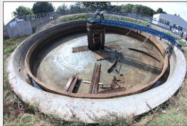
2. září 2011 – Demontáže původního vstrojení usazováku biofiltrů
