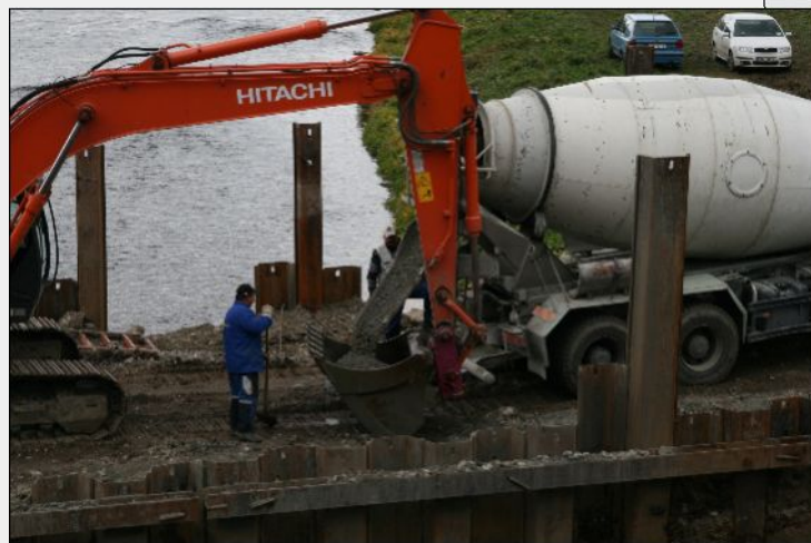
4. listopad 2010 – Doprava betonu do stavební jámy
