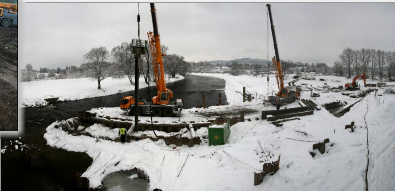
30. listopad 2010 – Rozebírání štětovnicových stěn levobřežní stavební jámy po položení potrubí shybky pod řekou Otavou (skládané panorama)
