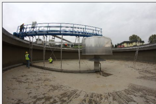
20.10.2011 – Ukončení sanace dosazovací nádrže DN 2, přejímka
