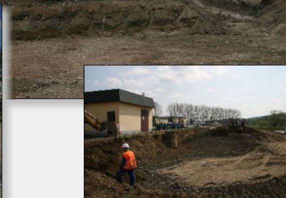
27. duben 2010 – Hloubení stavební jámy nových nádrží
