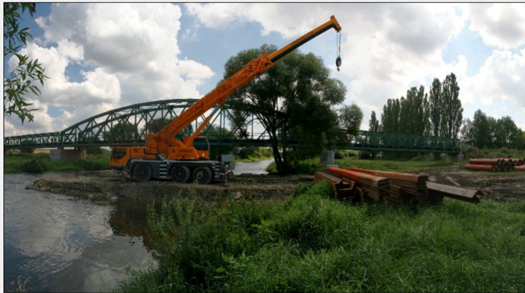
4. srpen 2010 – Násyp stavební jámy shybky pod Otavou, příprava na štětování stavební jámy
