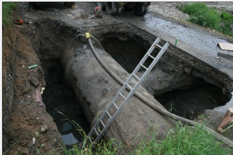
14. červen 2010 – Obnažení starého sběrače na zaústění do hlavního sběrače před ČOV
