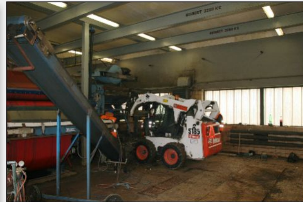
8. únor 2011 – Demontáž starého pásového lisu před rekonstrukcí kalového hospodářství
