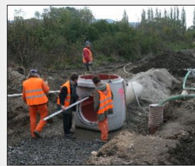
19. říjen 2010 – Montáž šachty na sběrači
