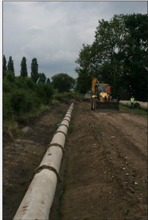
30. červenec 2010 – Obnažené staré potrubí sběrače před vybouráním
