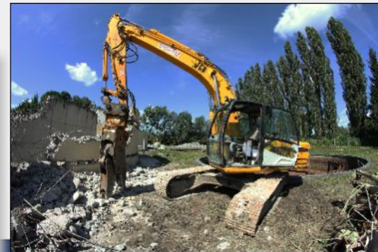
6. září 2011 – Demolice biofiltrové linky. Rozebírání biofiltru BF 1, odstraňování náplně BF.
