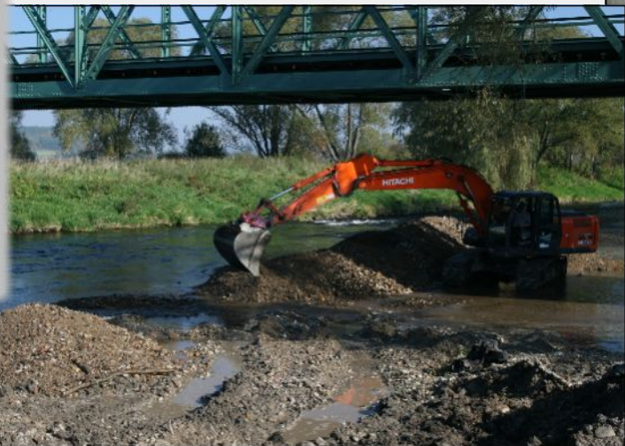
12. říjen 2010 – Likvidace pravobřežní stavební jámy po dokončení pokládky poloviny shybky pod řekou Otavou
