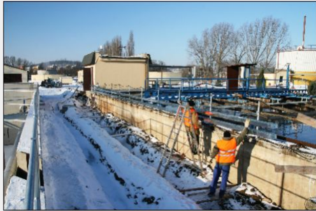
16. prosinec 2010 – Budování kabelových tras na usazovací nádrži
