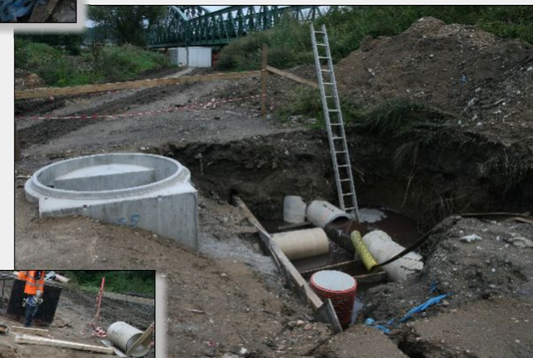
17. srpen 2010 – Výstavba propojení starého a nového sběrače za šybkami pod řekou Otavou
