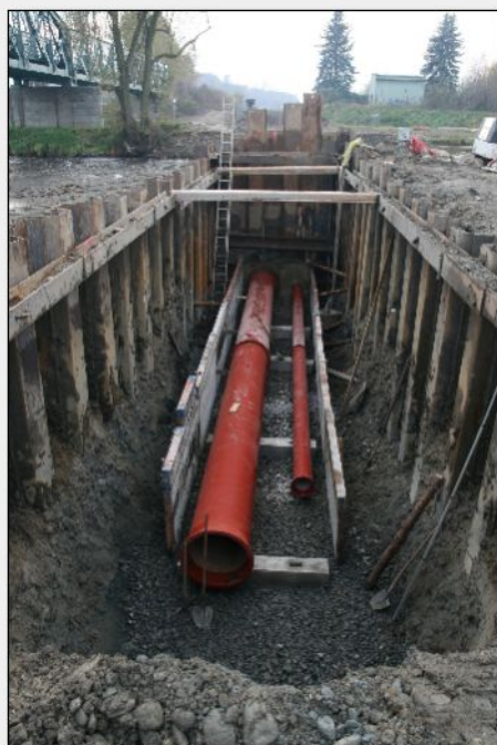
1. a 4. listopad 2010 – Pokládka a obetonování levobřežní části potrubí shybky pod řekou Otavou
