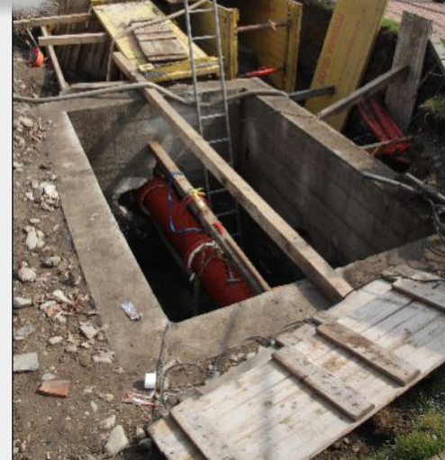
18. duben 2011 – Pokračování prací na přestavbě stávající čerpací stanice na dešťový oddělovač nového sběrače
