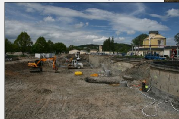
12. květen 2010 – Příprava dna stavební jámy pro betonáž základů nádrží
