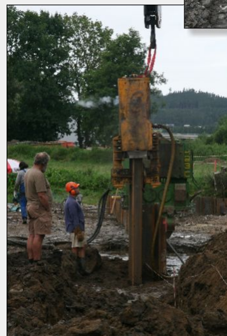
Pneumatické beranidlo pro štětování v kamenitém podloží
