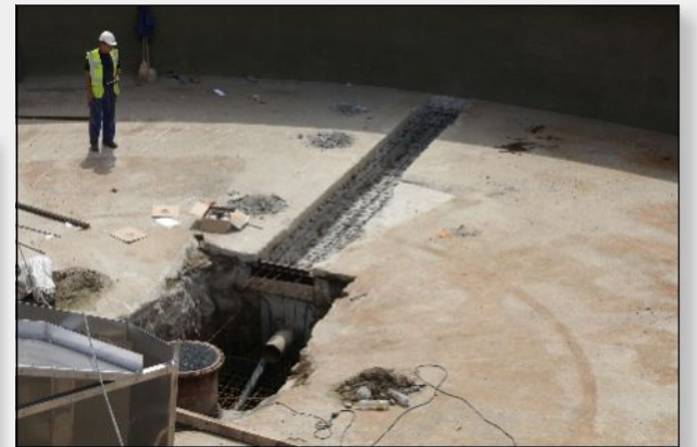
13. červen 2011 – Příprava betonáže zakrytí nového odkalovacího potrubí a kalové jímky
