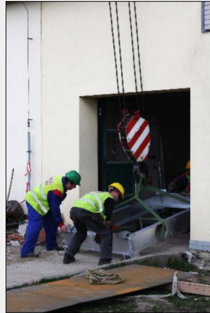
31. březen 2011 – Stěhování základu pod rotační zahušťovák kalu
