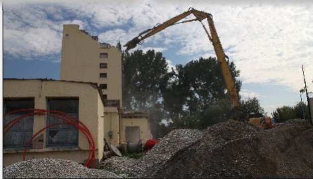
18. srpen 2011 – Bourání výstupní věže staré vyhnivací nádrže (rozkousání zdi čelistmi)
