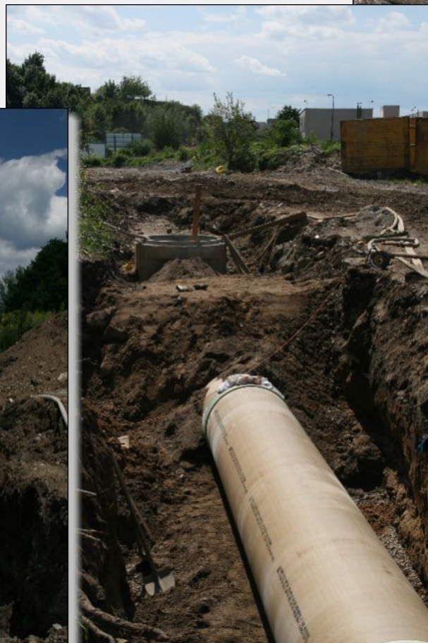
10. srpen 2010 – Pokračování pokládky pravobřežní části nového sběrače podél železničního náspu k řece
