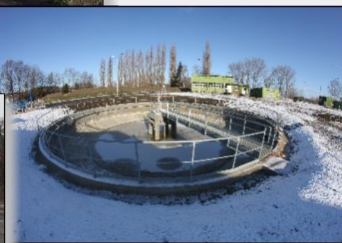
16. leden 2012 – Dokončené dešťové zdrže DZ 1 a DZ 2
