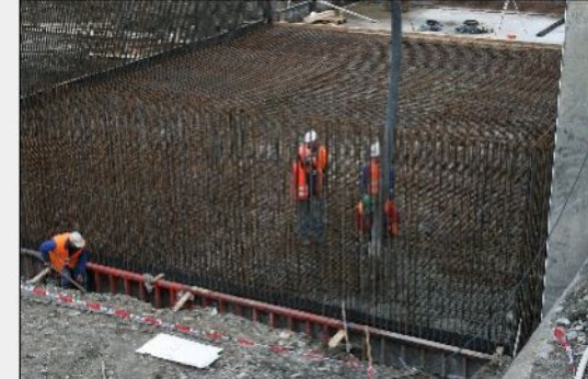
2. červen 2010 – Betonování první části dna nádrže nitrifikace
