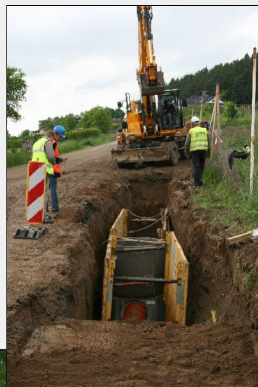
27. květen 2010 – Provádění výkopu a pokládky potrubí s ocelovým pažením
