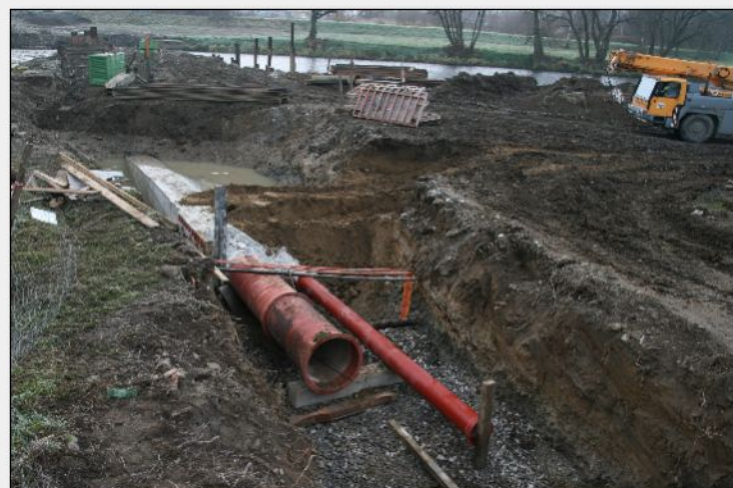
26. listopad 2010 – Pokládka sestupné levobřežní větve shybky pod řekou Otavou směrem od břehu řeky k manipulační a uzavírací šachtě shybky
