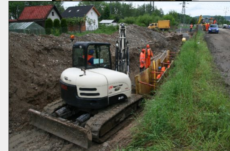
27. květen 2010 – Práce ve výkopu před Mutěnickým mostem
