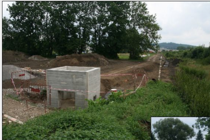
30. červenec 2010 – Spojná šachta s novým potrubím sběrače a obnažené původní levobřežní potrubí sběrače
