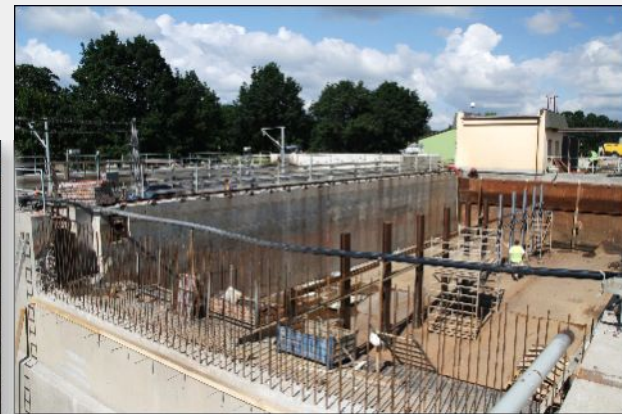
24. červen 2011 – Sanace usazovací nádrže, armování odtokového žlabu
