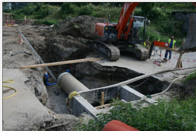
24. červen 2010 – Vybetonovaná spojná šachta na hlavním sběrači, počátek pokládky nového sběrače
