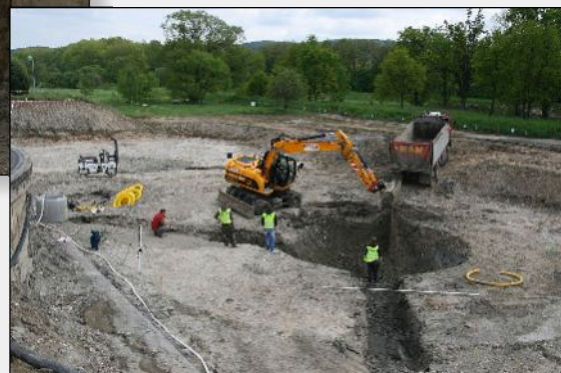
18.5.2010 – Dokončování jámy pro dosazovací nádrž DN 3
