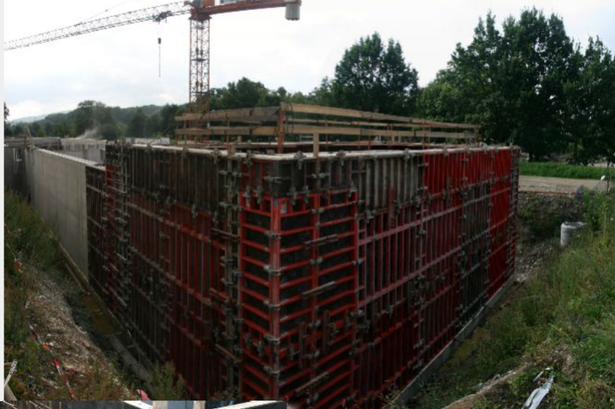
3. září 2010 – Betonování stěn nádrže regenerace kalu
