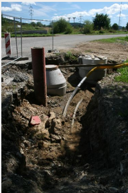
26. srpen 2010 – Napojování výtlačku z ČS Mutěnice na nový sběrač
