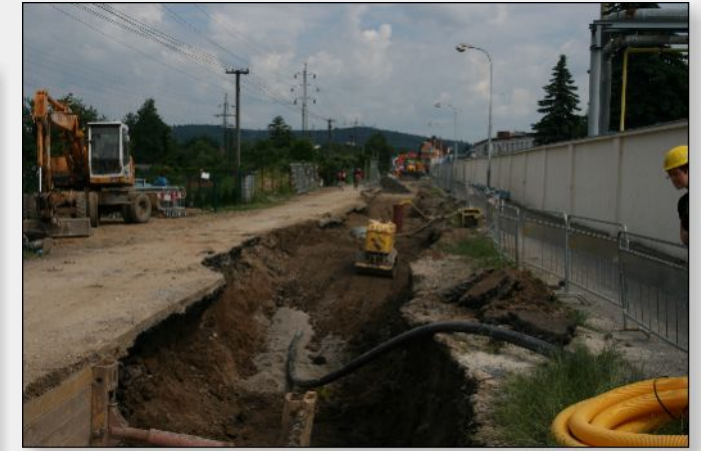
24. srpen 2010 – Postup prací na výkopu v Prácheňské ulici podél ČZ a.s.
