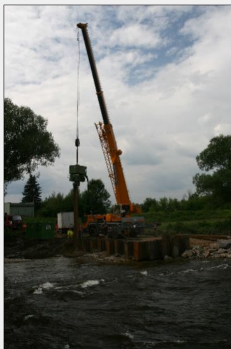
11. srpen 2010 – Práce se štětovnicemi při štětování stavební jámy shybky pod řekou Otavou
