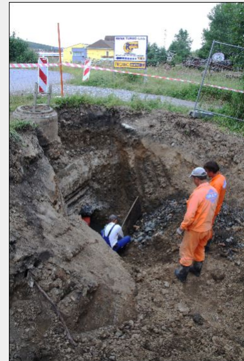
25. červenec 2011 – Napojování nového potrubí sběrače do stávající odlehčovací komory pod silničním mostem
