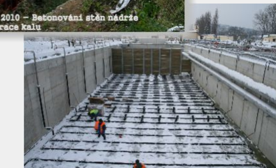
2. prosinec 2010 – Montáž aeračních elementů nové de/nitrifikace
