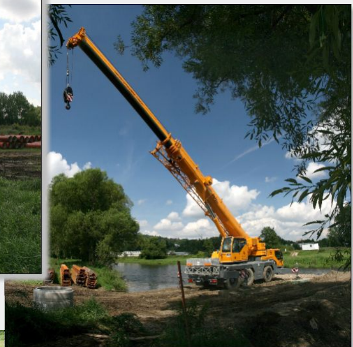
4. srpen 2010 – Násyp stavební jámy shybky pod Otavou, příprava na štětování stavební jámy. Připravená těžká technika.
