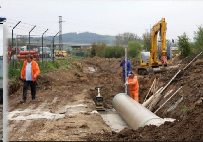
27. duben 2011 – Pokládka nového levobřežního sběrače se již blíží ke svému cíli
