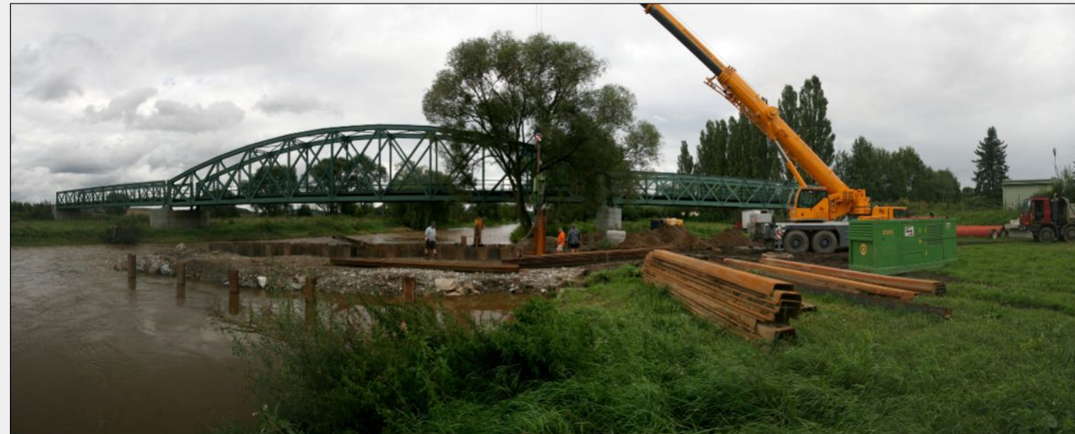
16. srpen 2010 – Pokračování prací na štětování stavební jámy shybky pod řekou Otavou
