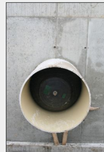
14. prosinec 2010 – Zkouška vodotěsnosti shybky pod řekou Otavou – těsnění vstupního potrubí do šachty vakem
