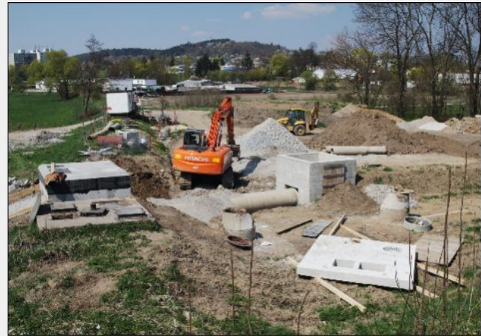
18. duben 2011 – Propojení nového potrubí levobřežního sběrače s novou sýbkou pod řekou Otavou
