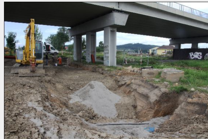
25. červenec 2011 – Dokončování pokládky potrubí pod silničním mostem na Písecké ulici
