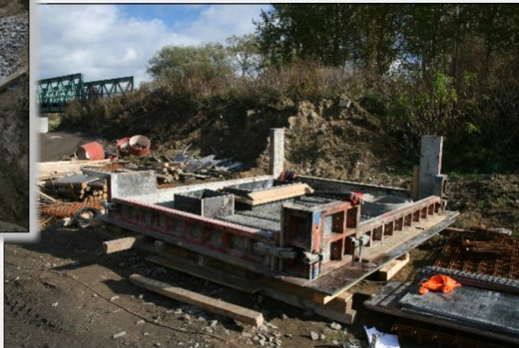
26. říjen 2010 – Příprava formy pro betonáž stropní desky koncové armaturní šachty shybky
