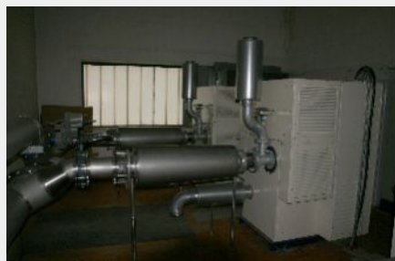
1. prosinec 2010 – Nová turbodmychadla v dmychárně
