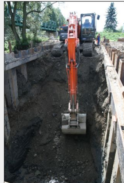
24. a 25. srpen 2010 – Hloubení stavební jámy shybky pod ochranou ocelových štětovnic
