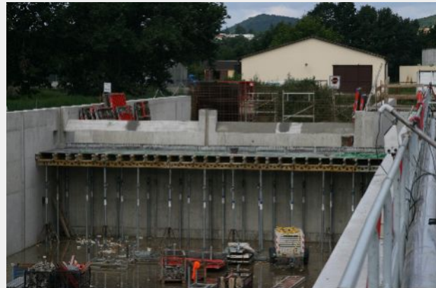
19. srpen 2010 – Armování nátokového žlabu aktivačních linek
