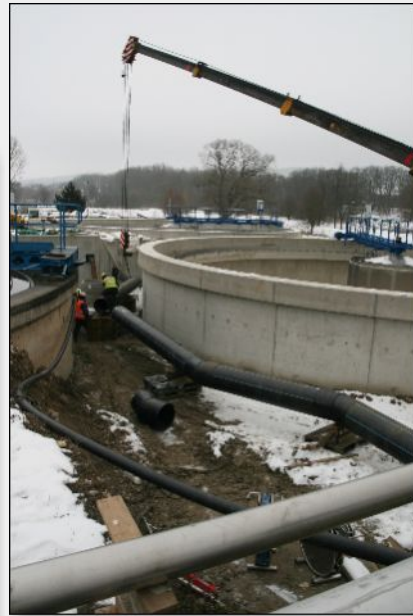
21. leden 2011 – Pokládka potrubí vratného kalu aktivačních linek
