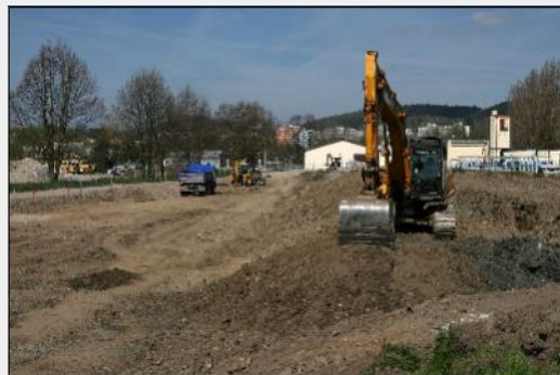
22. duben 2010 – Hloubení stavební jámy pro nové nádrže
