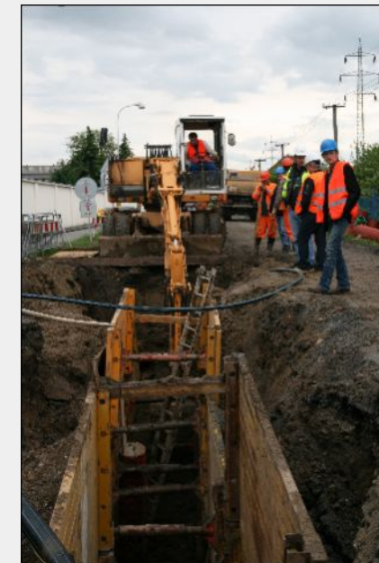
27. květen 2010 – Práce ve výkopu v Prácheňské ulici podél ČZ a.s.
