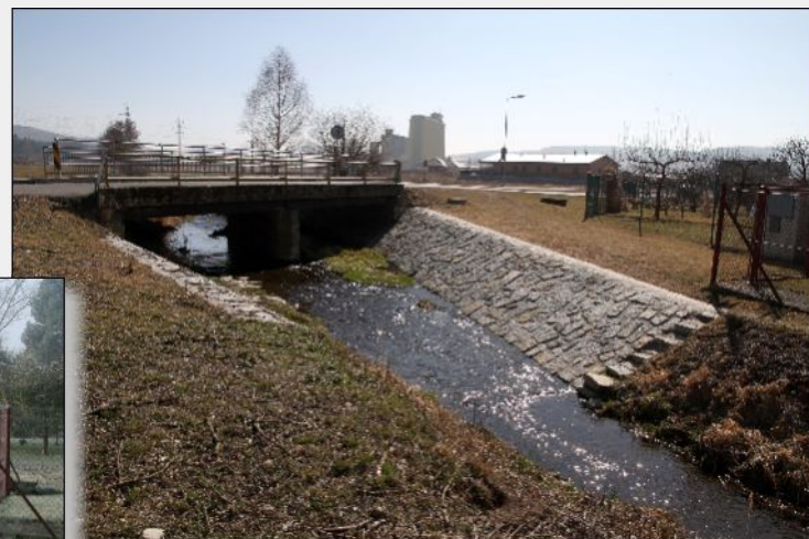
25. listopad 2011 – Obnovené kamenného obložení koryta Svarýšovského potoka v místě křížení s novým sběračem
