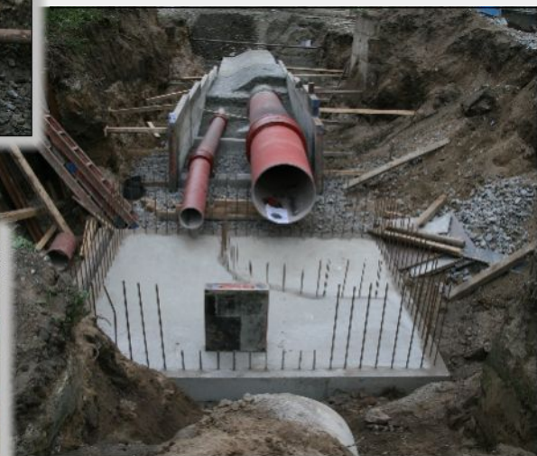
15. říjen 2010 – Základy pro koncovou šachtu pravobřežní části shybky pod řekou Otavou
