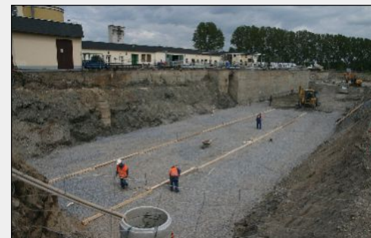
18. červen 2010 – Úpravy dna před betonováním základové desky
