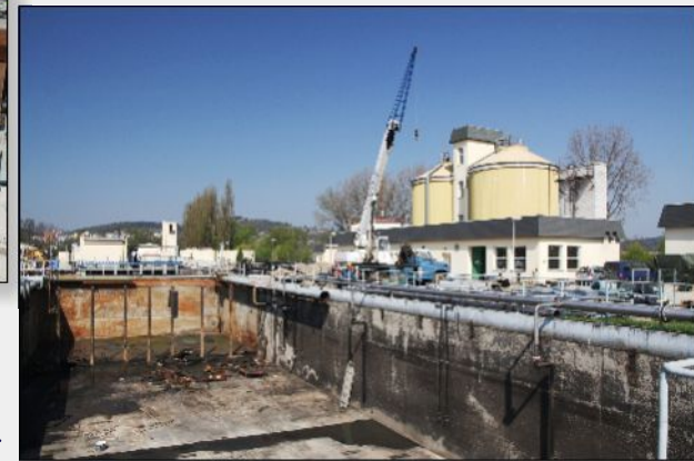
20. duben 2011 – Sanace dosazovacích nádrží – pískování povrchů
