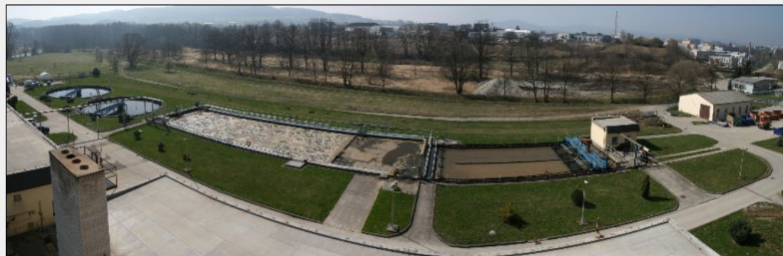
8. duben 2010 – Před intenzifikací – pohled z vrcholu vyhnivací nádrže
