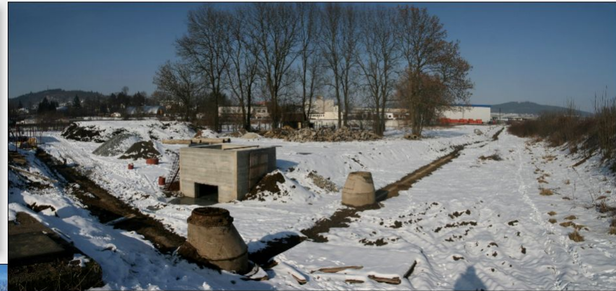
31. leden 2011 – Staveniště levobřežní části sběrače pod sněhem
