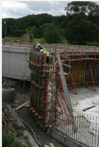
16. srpen 2010 – Armování stěny nádrže DN 3
