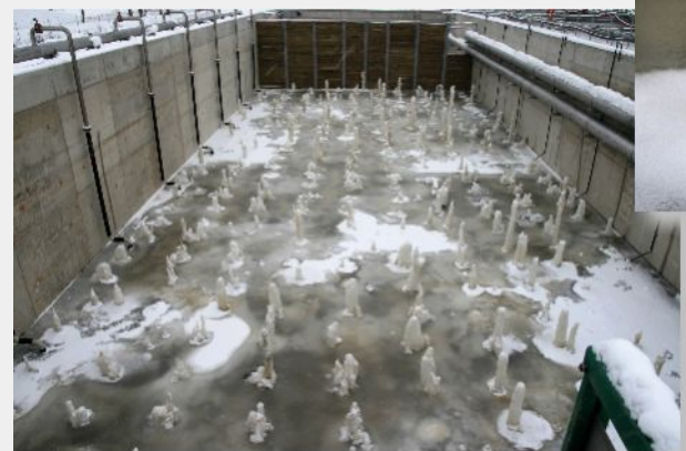
6. prosinec 2010 – Zkoušení aeračních elementů nové nádrže de/nitrifikace – ledové krápníky
