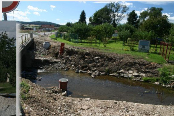
26. srpen 2010 – přechod sběrače pod Svarýšovským potokem
