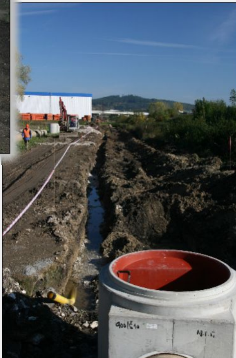
8. říjen 2010 – Příprava výkopu pro pokládku nového laminátového potrubí levobřežní části sběrače
