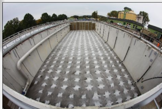
7. říjen 2011 – Zkouška aeračního systému staré aktivace
