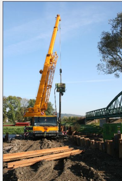
8. říjen 2010 – Odstraňování štětovic po zasypání stavební jámy shybky pod Otavou
