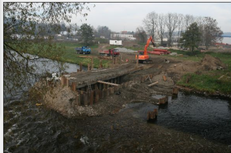
1. listopad 2010 – Hloubení levobřežní stavební jámy shybky pro pokládku potrubí shybky
