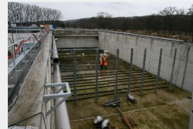
23. listopad 2010 – Instalace aeračních roštů do nové nádrže nitrifikace
