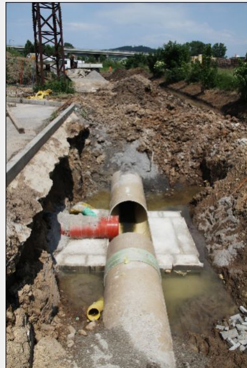
3. červen 2011 – Výstavba přípojné šachty na novém levobřežním sběrači
