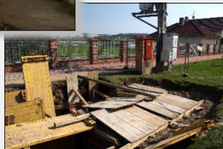
18. duben 2011 – práce na přestavbě stávající čerpací stanice na dešťový oddělovač nového sběrače
