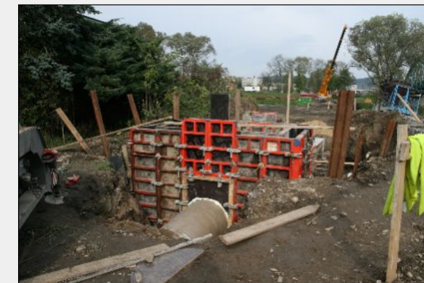
19. říjen 2010 – Napojení nového sběrače na budoucí výstupní armaturní šachtu nové šybkou pod Otavou
