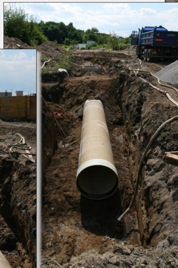
10. srpen 2010 – Pokračování pokládky pravobřežní části nového sběrače podél železničního náspu k řece
