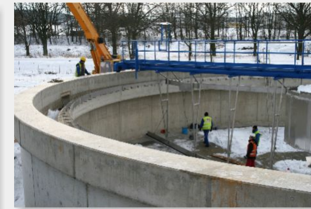
9. prosinec 2010 – Montáž technologie nádrže dosazováku DN 3
