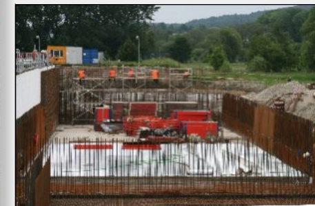
17. červen 2010 – Armování stěn nové de/nitrifikační nádrže
