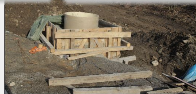
10. únor 2011 – Výstavba šachty s kanalizační přípojkou na novém sběrači
