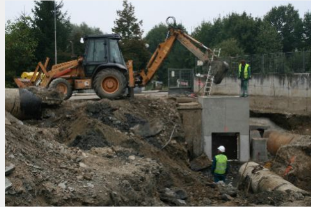
24. září 2010 – Betonáž spojné a uzavírací šachty na nátoku ČOV
