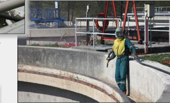
20. duben 2011 – Sanace dosazovacích nádrží – pískování povrchů
