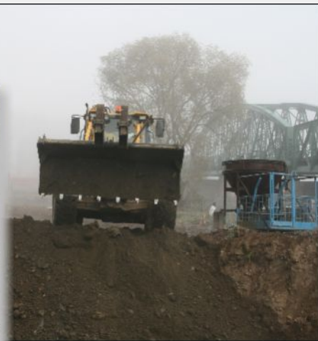
1. listopad 2010 – Hloubení levobřežní stavební jámy shybky pro pokládku potrubí shybky
