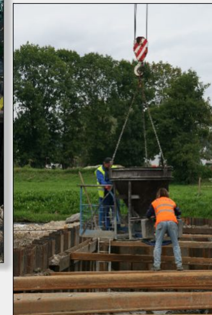
1. září 2010 – Položené litinové potrubí shybky pod betonovou zálivkou
