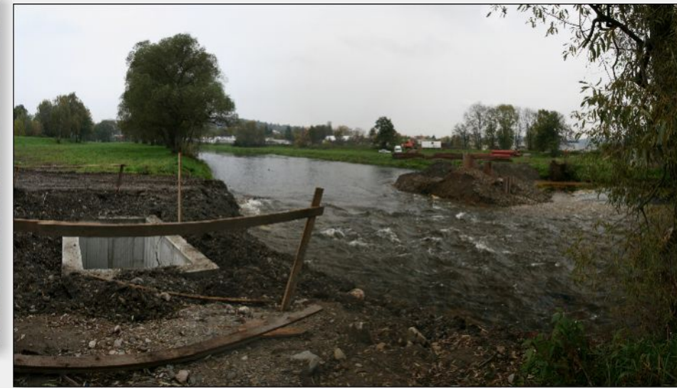
18. říjen 2010 – Přenesení stavební jámy shybky na levý břeh Otavy. Pravobřežní manipulační šachta na potrubí shybky
