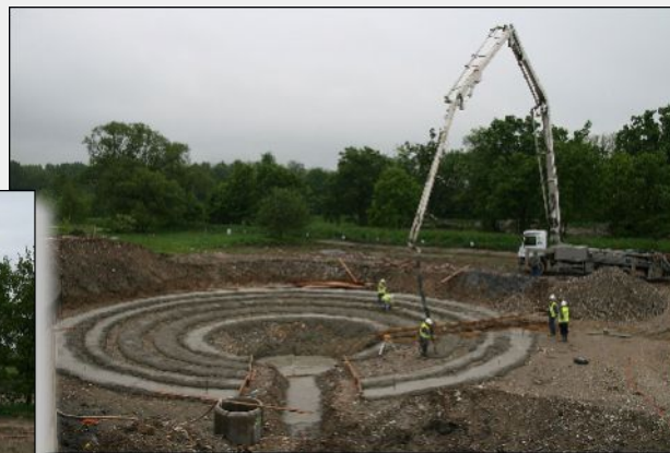
26. květen 2010 – Betonování základové desky dosazovací nádrže DN 4
