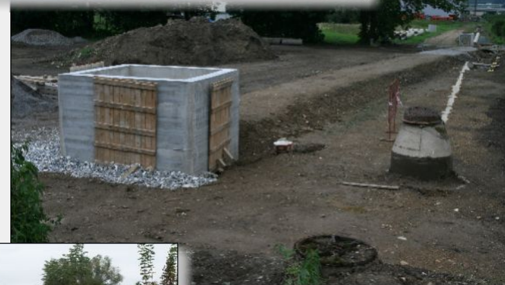
18. srpen 2010 – Staveniště levobřežní části sběrače
