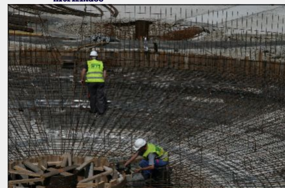
8. červenec 2010 – Armování a bednění dna dosazovací nádrže DN 4
