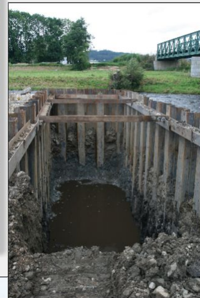
24. a 25. srpen 2010 – Hloubení stavební jámy shybky pod ochranou ocelových štětovnic
