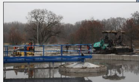
23. listopad 2011 – Pokládka asfaltové vozovky komunikací
